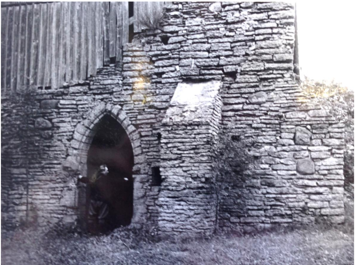
64. Kabeli läänekülg 1964. aastal. EAA.5238.1.561
