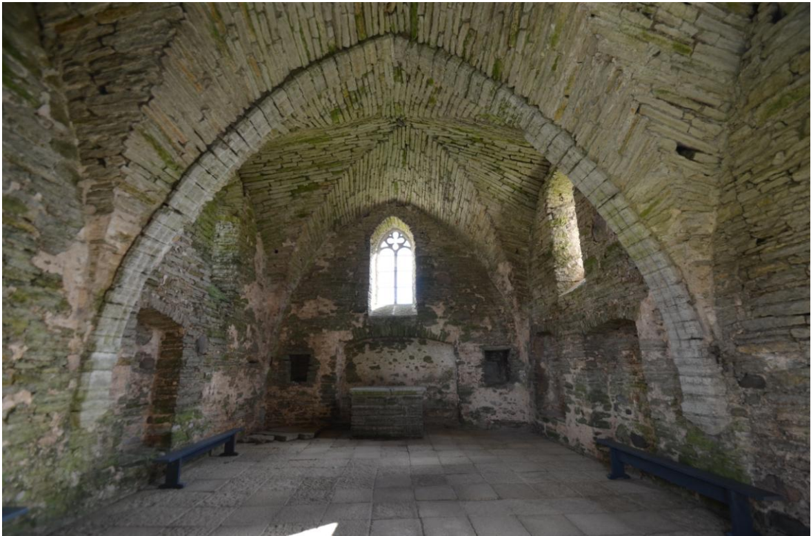
7. Saha kabeli sisevaade. Foto: Mari Luukas, 11.08.2016.
