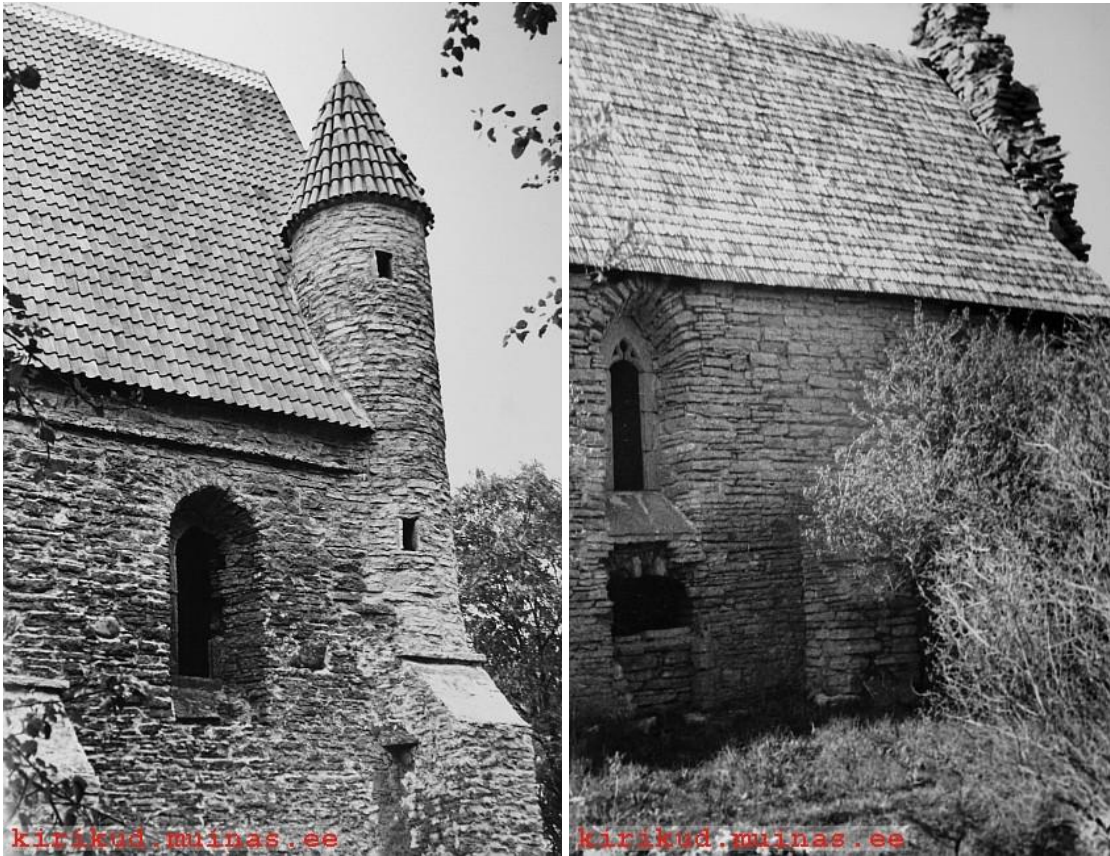
70-71. Saha kabeli restaureerimistööd 1962-1969. ERA.T-76.1.1041
