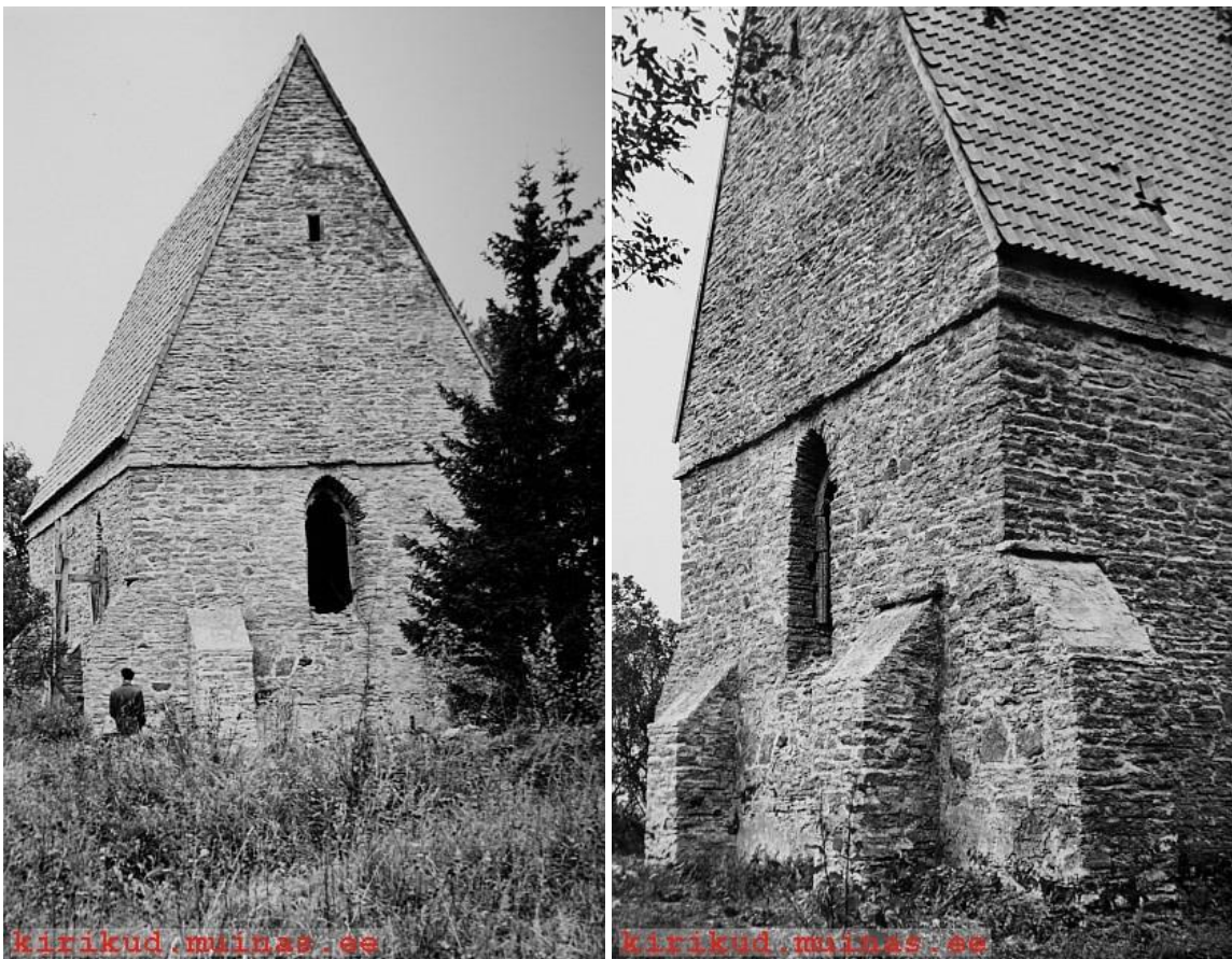
68-69. Saha kabeli restaureerimistööd 1962-1969. ERA.T-76.1.1041
