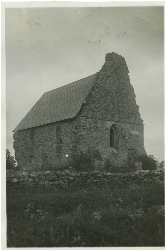
36. Vaade kabelile kagust, 1930ndad TLM F 1732
