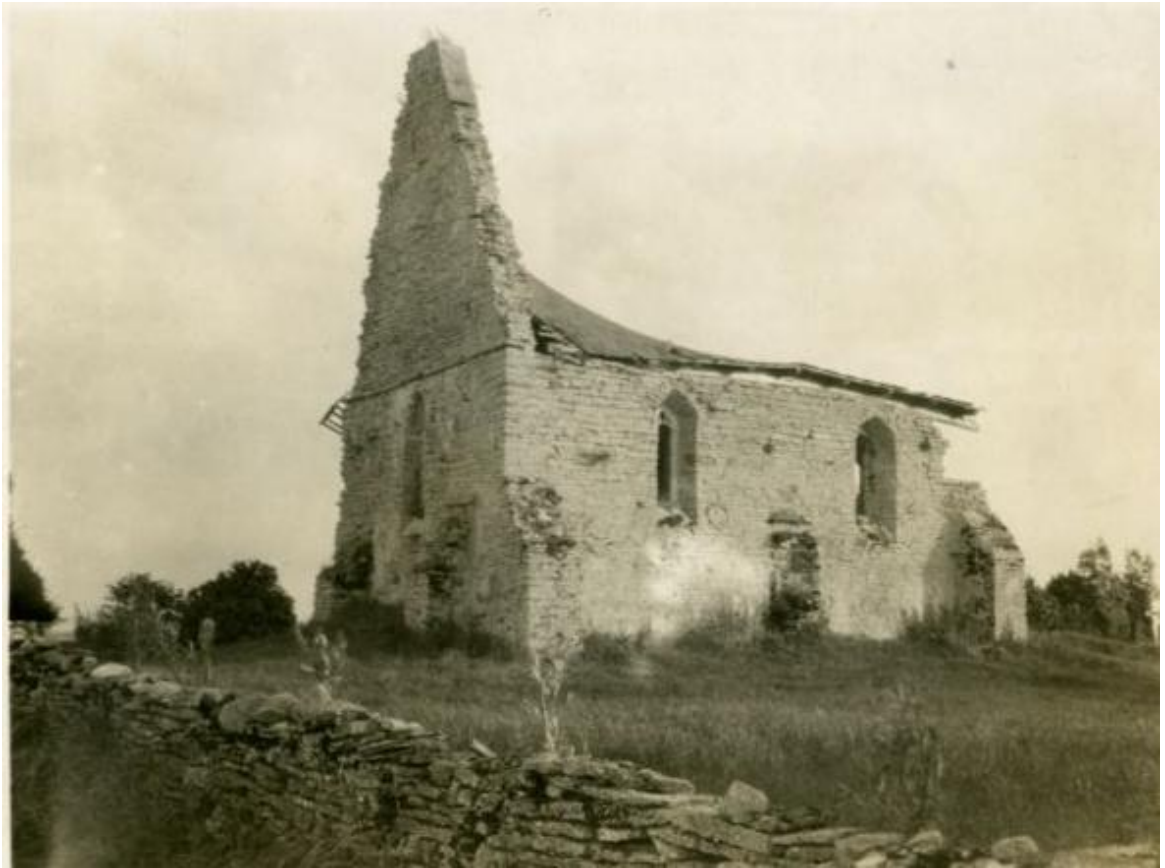
26. Vaade kabelile põhjast, 11. august 1924. AM F18389 ja TLA.884.1.666
