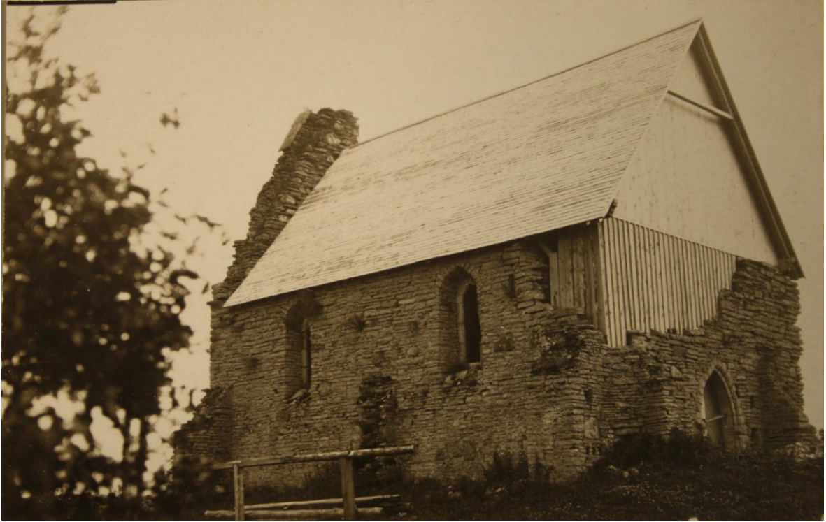
32. Saha kabel, vaade loodest, tõenäoliselt vahetult peale parandustöid 1928. AM F 14695
