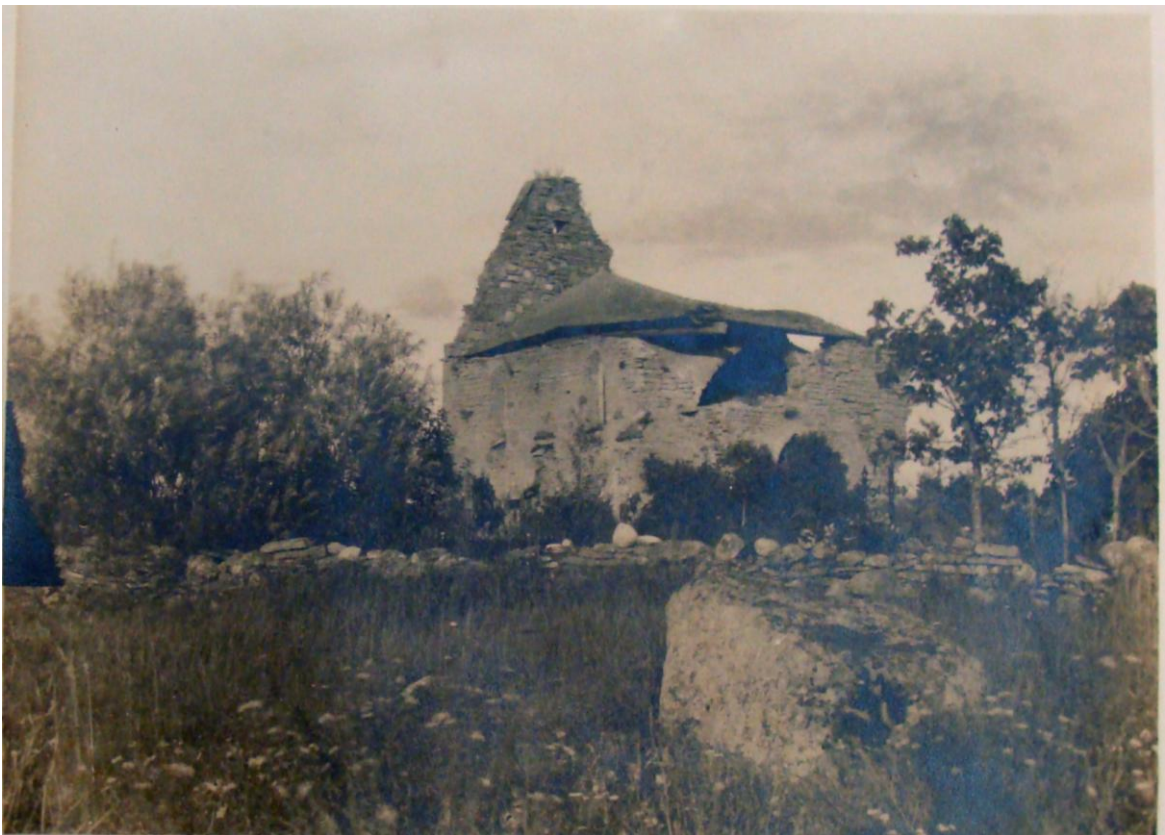
27. Vaade kabelile läänest. 11. august 1924. EMM F 124:16 ja TLA.884.1.666
