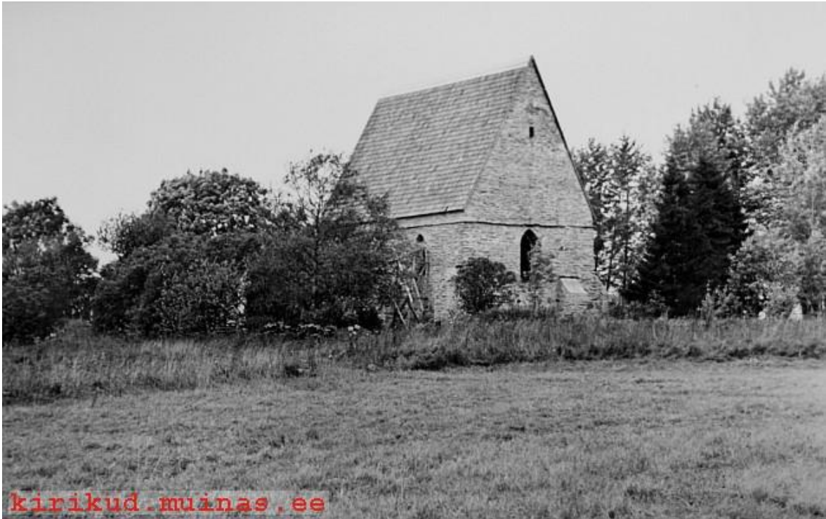
67. Saha kabeli restaureerimistööd 1962-1969. ERA.T-76.1.1041
