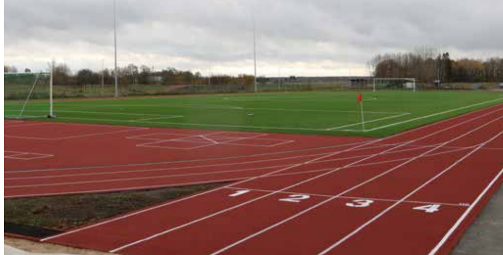
Teise etapi ehitustöödega ehitati välja kunstmuruga jalgpalliväljak, staadioni jooksuringid ning tervisespordirada.
