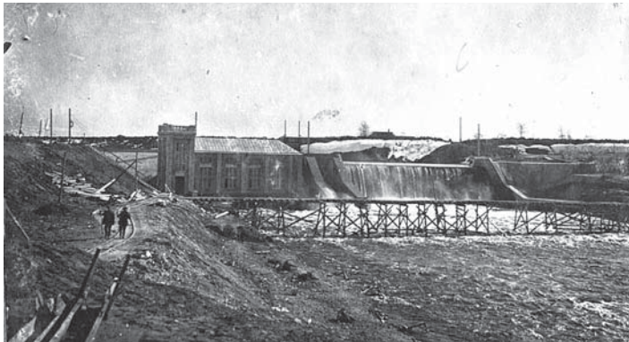
Ehitustööd alustati 1922. aastal ning elektrit hakkas jaam tootma 17. aprillil 1924. aastal.
